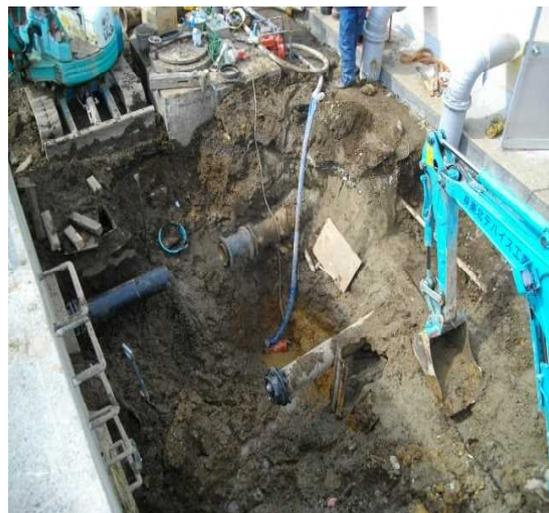
【地震で壊れた水道管の復旧工事】
