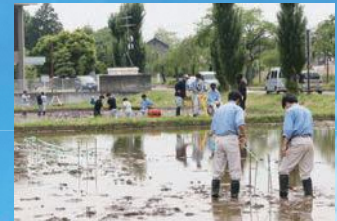
測量: 田んぼアートの重要な測量を鏡石建設業協同組合と協同で行っています。
