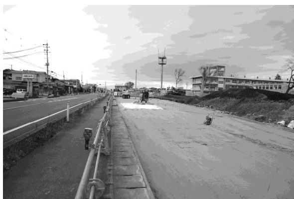
拡幅事業中の国道4号
