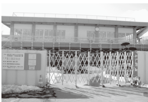
改修工事が進む中学校
