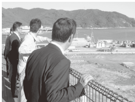
高台から工事状況を視察（女川町）
