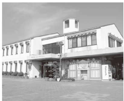
改修されるコミュニティセンター
