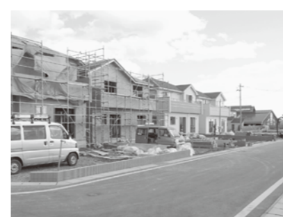
住宅が次々と建築されている 駅東第1土地区画整理事業（第1工区）
