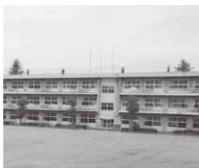
解体される一小校舎
