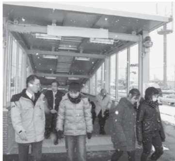
拡幅工事が進む国道（地下歩道）
