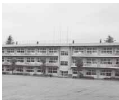
解体される一小校舎
