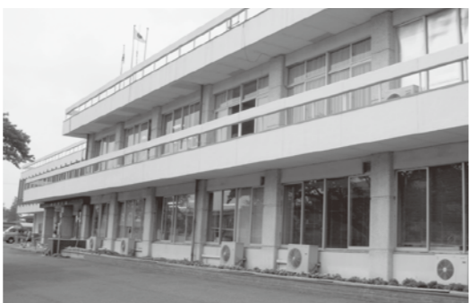
耐震化補修される役場庁舎
