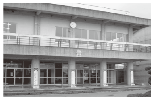
大規模改修される中学校校舎
