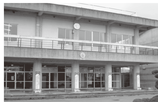
大規模改修される中学校校舎
