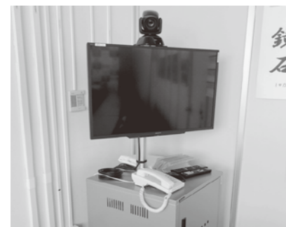
県総合情報ネットワークシステム
