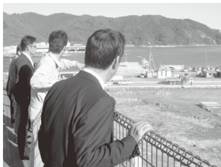
高台から工事状況を視察（女川町）
