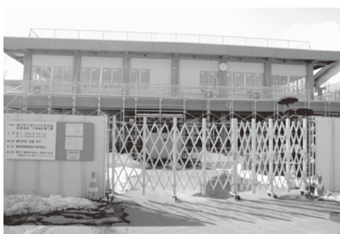
改修工事が進む中学校
