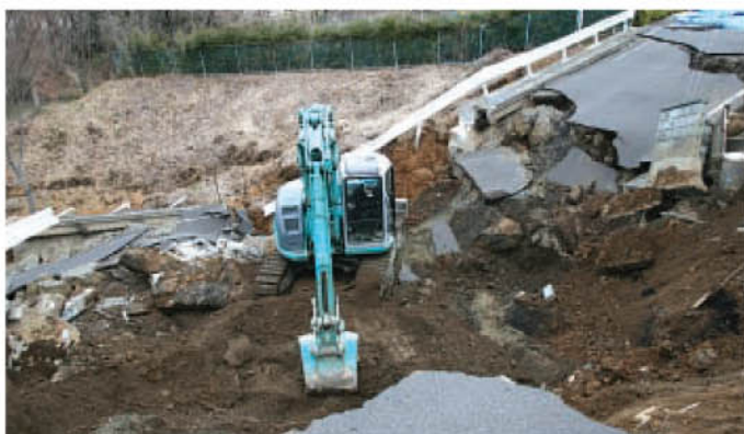
▲多くの協力企業が復旧のため重機とともに奔走しました
