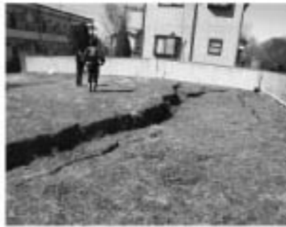
▲住宅地にも大きな亀裂が生じ家屋が真っ二つに(不陽沼)
