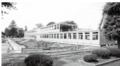
▲急ピッチで設置が進む一小仮設校舎
