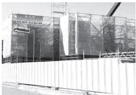
建築が進む災害公営住宅
