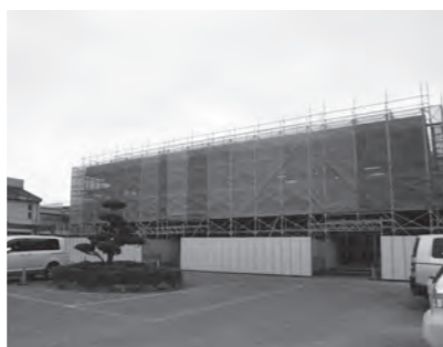
中学校耐震補強・大規模改修工事
