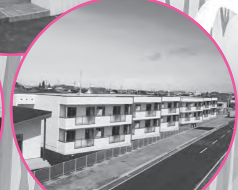
3月25日(水)町災害公営住宅完成
