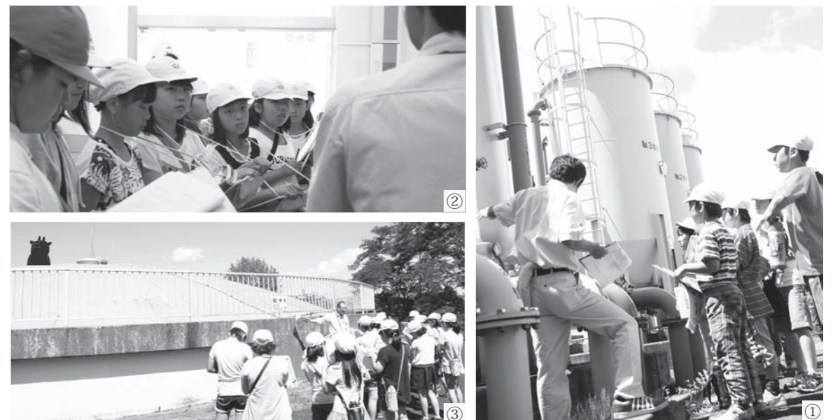
① 中央の大きなタンクが「ろ過装置」です ② 「中央監視盤」の説明を真剣に聞く児童たち ③ 敷地の中央には大きな「配水池」があります
