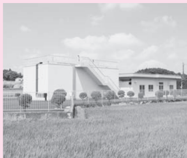
改修された成田浄水場
