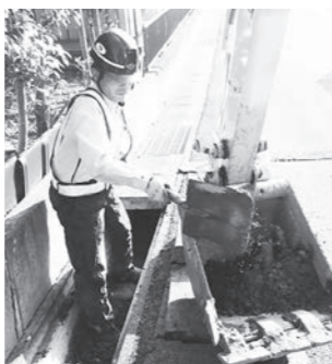
側溝の堆積物撤去作業の様子
