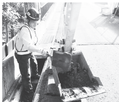
側溝の堆積物撤去作業の様子
