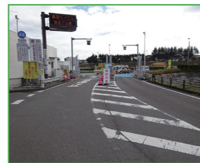
下り側 ETC ゲート改修
