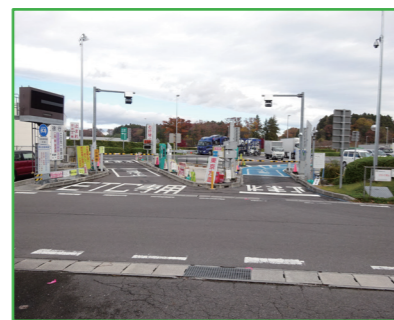
上り側 ETC ゲート改修
