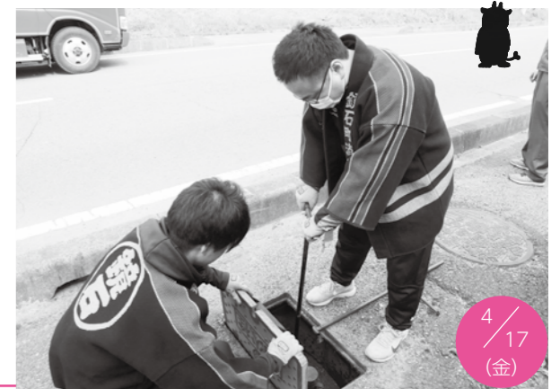
消火栓を確認する団員ら
