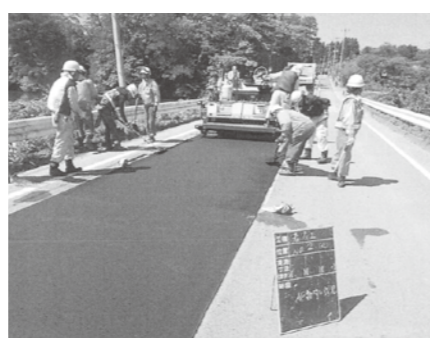
福島県沖地震で損傷した道路の復旧工事
