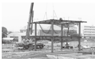
工事が進む建設現場
