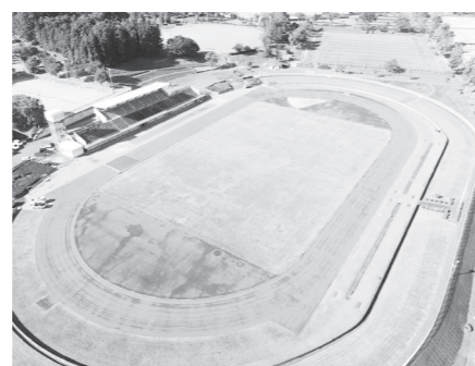
改修工事が予定行われている陸上競技場
