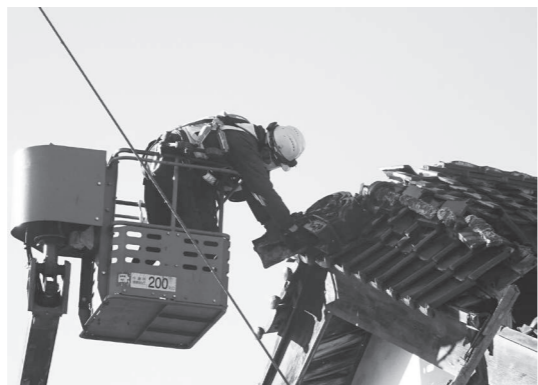
高所作業車で落ちそうな瓦を取り除く様子
