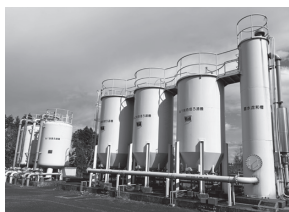
改修工事予定の桜岡浄水場
