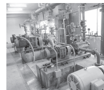
配水ポンプ交換
