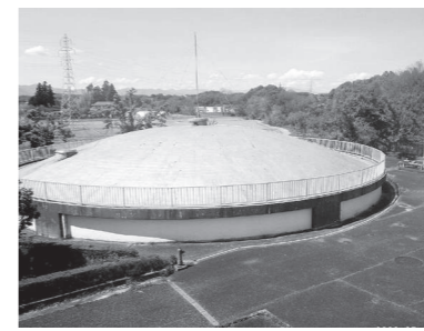
改修する桜岡浄水場
