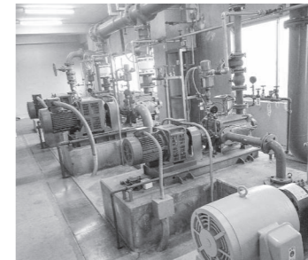
配水ポンプ交換
