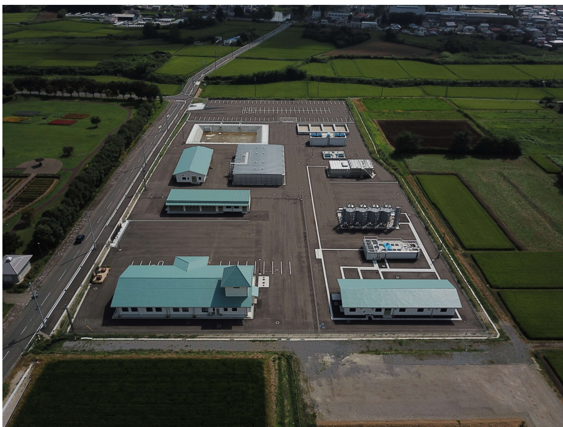
鏡石浄水場 令和 4 年 9 月 30 日完成
