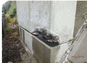
愛宕山橋 :PCラーメン橋 (東北道の跨道橋) 判定区分Ⅱ(健全度C) 橋脚(垂直材)に剥離・鉄筋露出あり。 凍結防止剤に起因する塩害により、内部鋼材の腐食が進行する可能性がある。
