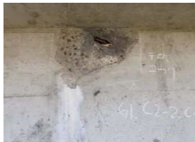
成竜橋 :PCT桁橋 (阿武隈川を跨ぐ長大橋) 判定区分Ⅱ(健全度C) ボステン桁ウェブ、上フランジ下面に剥離、鉄筋露出あり。 部材内部への雨水の浸入により、内部鋼材の腐食が進行する可能性がある。
