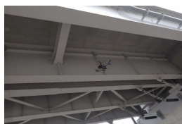
ドローンによる桁下の点検
