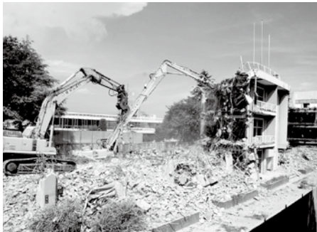
▲長年親しまれた校舎の解体工事
