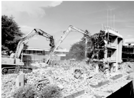
▲長年親しまれた校舎の解体工事
