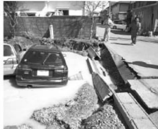
▲液状化現象により地面が陥没し、水没した車両(駅前)
