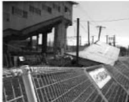
▲JR磐石駅も壊滅的な被害に見舞われた
