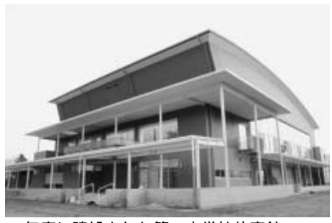
18年度に建設された第一小学校体育館
