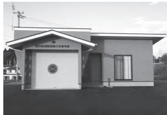
新しい町消防団第六分団屯所完成
