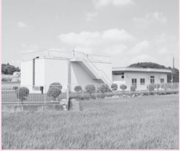
改修された成田浄水場
