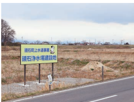
新浄水場建設予定地（緑町地内）
