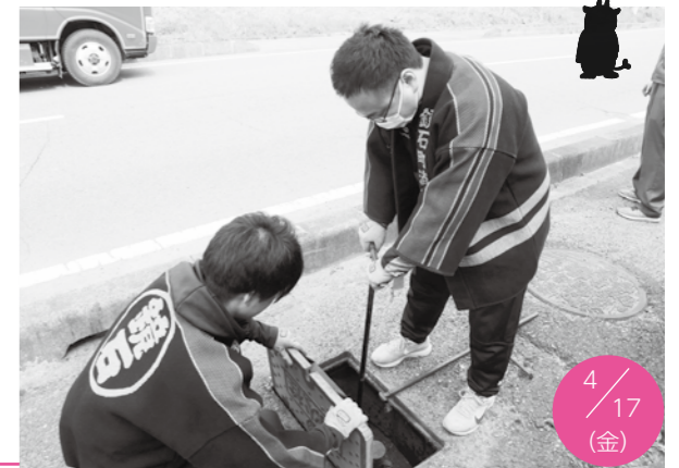
消火栓を確認する団員ら
