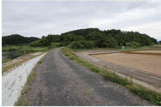
仮復旧が完了した堤防 (令和2年9月23日撮影)
