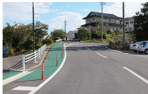
安全対策工事を行った町道仁井田笠石線
