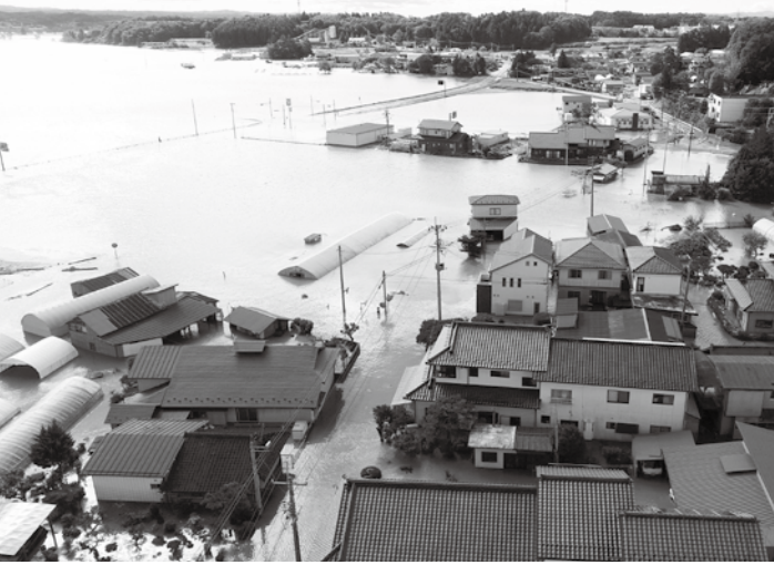
東日本台風で多くの住宅が浸水した成田地区（令和元年10月）
