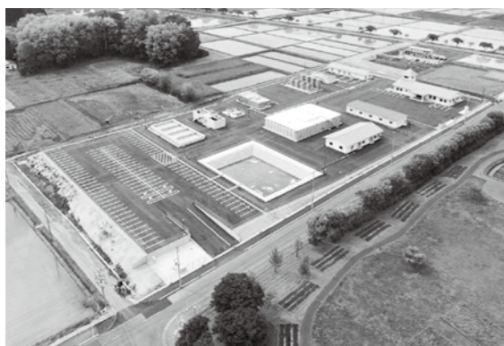
緑町地内に鏡石浄水場が完成 (令和4年)
