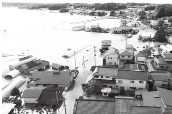
令和元年東日本台風により成田地区が浸水 (令和元年)
