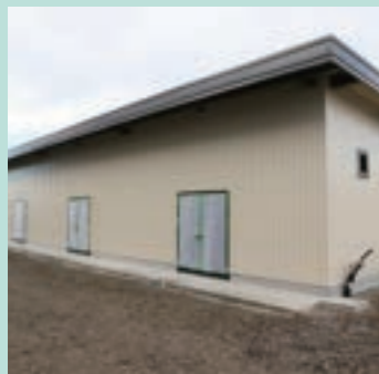
施設北側には倉庫を設置
