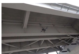
ドローンによる桁下の点検
